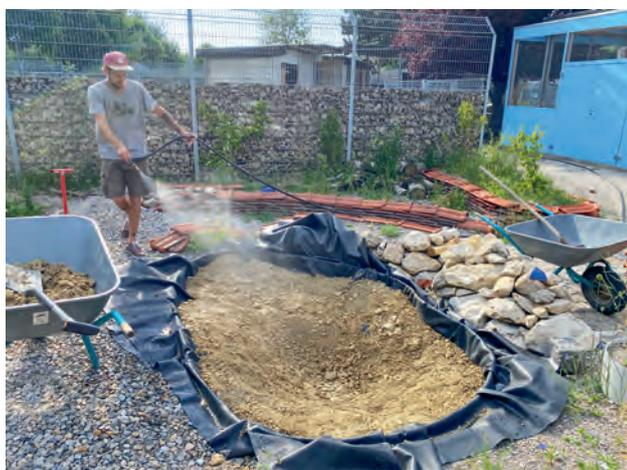
Auf das Vlies kam eine Kautschuk-Folie (EPDM-Folie) – ohne Weichmacher. Diese ist außerdem viel langlebiger als PVC-Folie. Darauf folgte eine Lehmschicht, die wiederum von der oberen Seite als Schutzschicht für die Folie dient.
